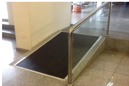
Rampa interior en Regional Santa Cruz
