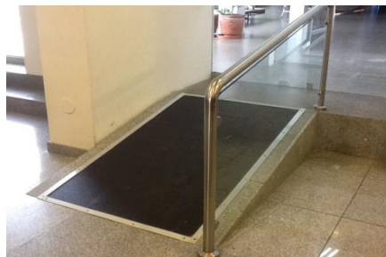
Rampa interior en Regional Santa Cruz
