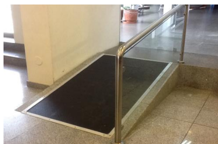
Rampa interior en Regional Santa Cruz
