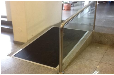
Rampa interior en Regional Santa Cruz
